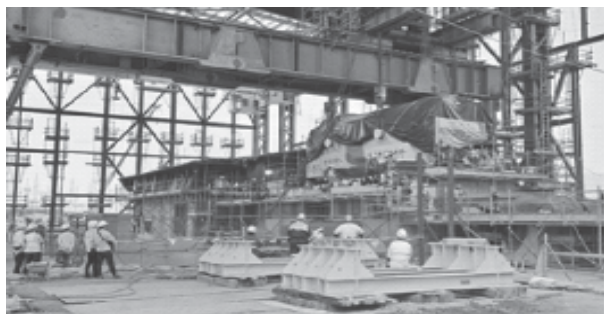
Máy phát điện được đưa vào vị trí lắp đặt
