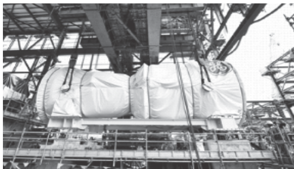
Tuabin khí được đưa vào vị trí lắp đặt an toàn
